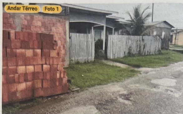
Frente da casa com material pra murar
