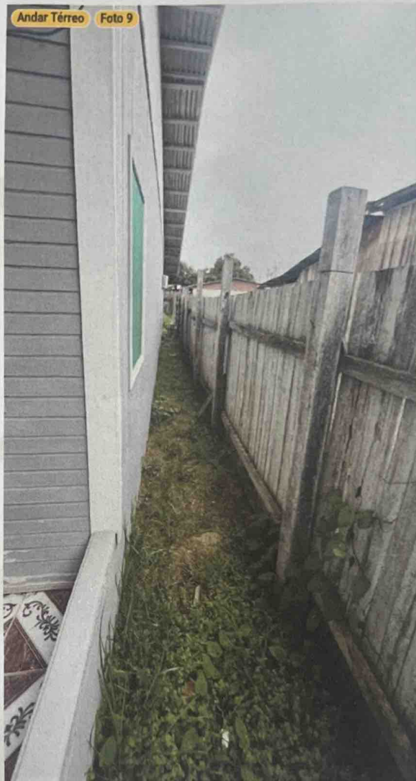
Corredor lateral direita
