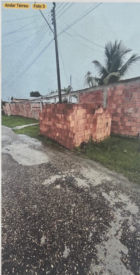
Material para construção dos muros geral
