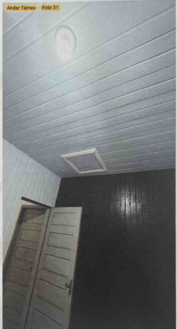
Escotilha de manutenções - forro do quarto
