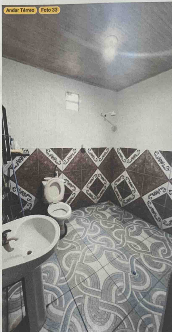
Banheiro social - foto 1
