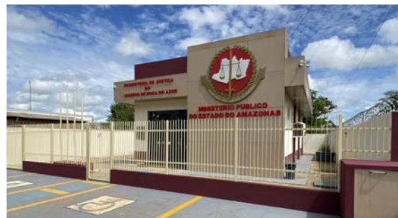
Figura - Construção de Promotoria de Justiça de Boca do Acre – MPAM.
