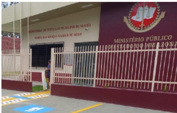
Figura - Construção de Promotoria de Justiça de Maués – MPAM.
