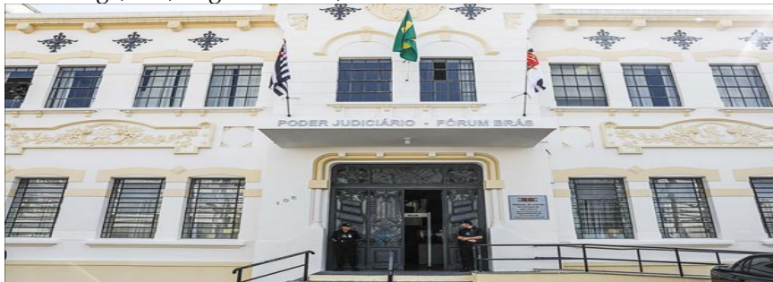
Figura 2 - Foto da fachada restaurada do Fórum do Brás/SP, na Rua Piratininga, 105, Região Central,
