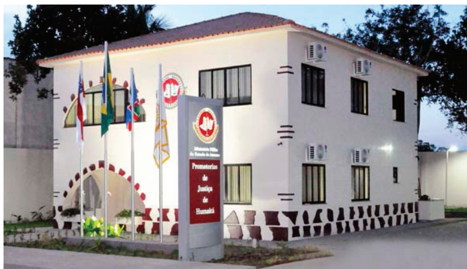
Imagem do Prédio da Comarca de Humaitá após a reforma
